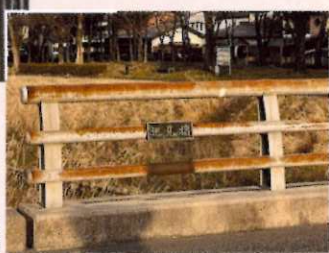
春日井市八田川に架かる巡見橋
