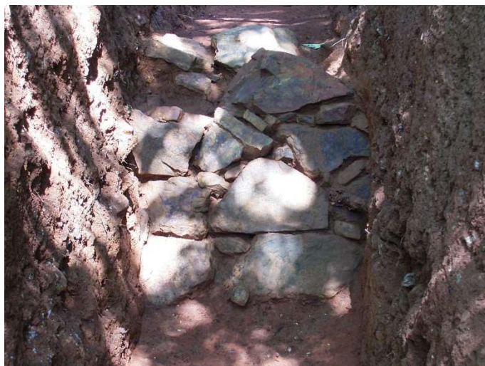
写真8 石積（谷側）検出状況 [第2次試掘調査]
