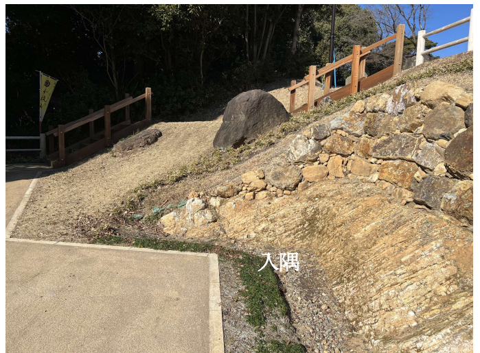
写真3 岩盤加工による入隅部（復元整備済み）
