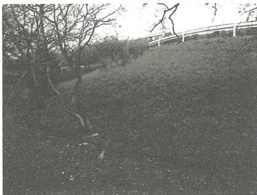
写真3-13 市道年上坂24号線下の法面
