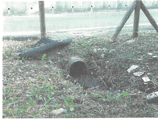
写真 3-17 市道側溝からの流入口
