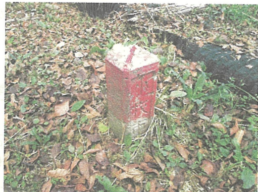
写真3-23 コンクリート製境界杭
