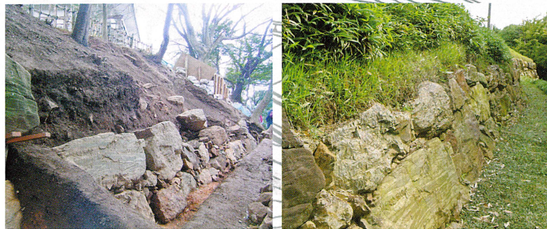
①残存するのは基底部付近の2～3段でさらに3～4段石垣が積まれていたと推定される
