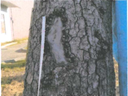
東の松 北面開口部 (補修済み)
