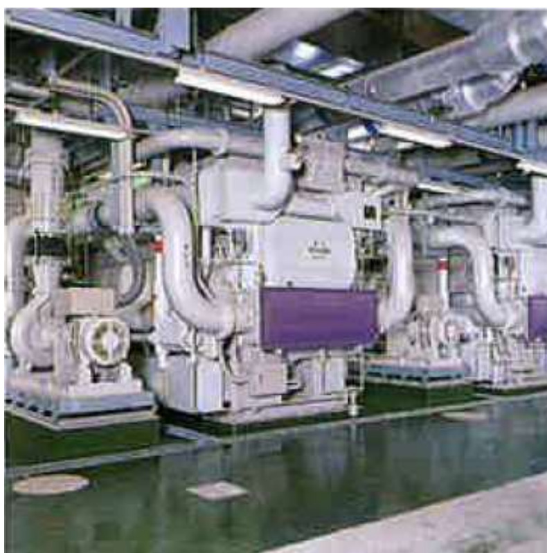
▲蒸気吸収冷凍機（1,100RT）
