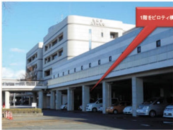
【上下水道局庁舎のかさ上げ例】
