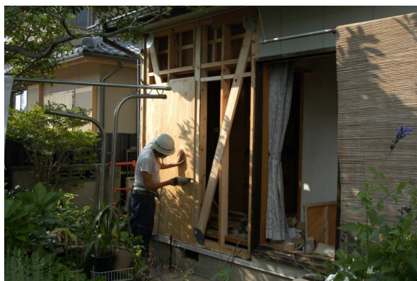
【図表-83】 耐震改修工事の例
