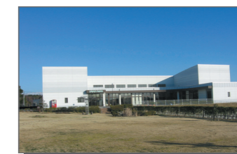
リサイクルプラザ プラザハウス
