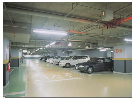
小牧駅地下駐車場
