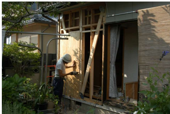
【 耐震改修工事の例 】
