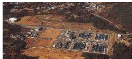
(写真) 犬山浄水場
