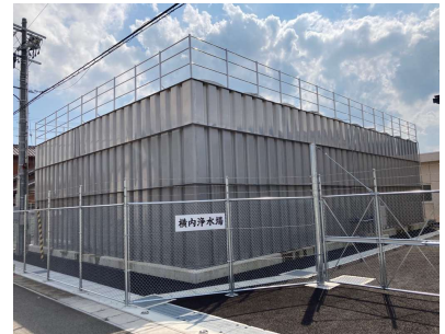
横内浄水場(横内)
