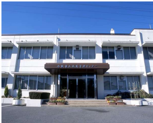
上水道管理センター
