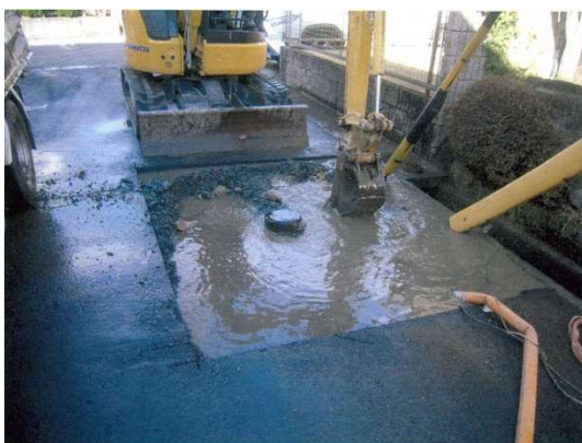
漏水修繕工事の様子
