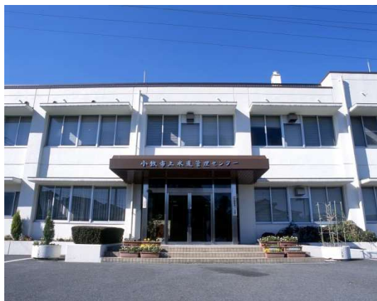
上水道管理センター
