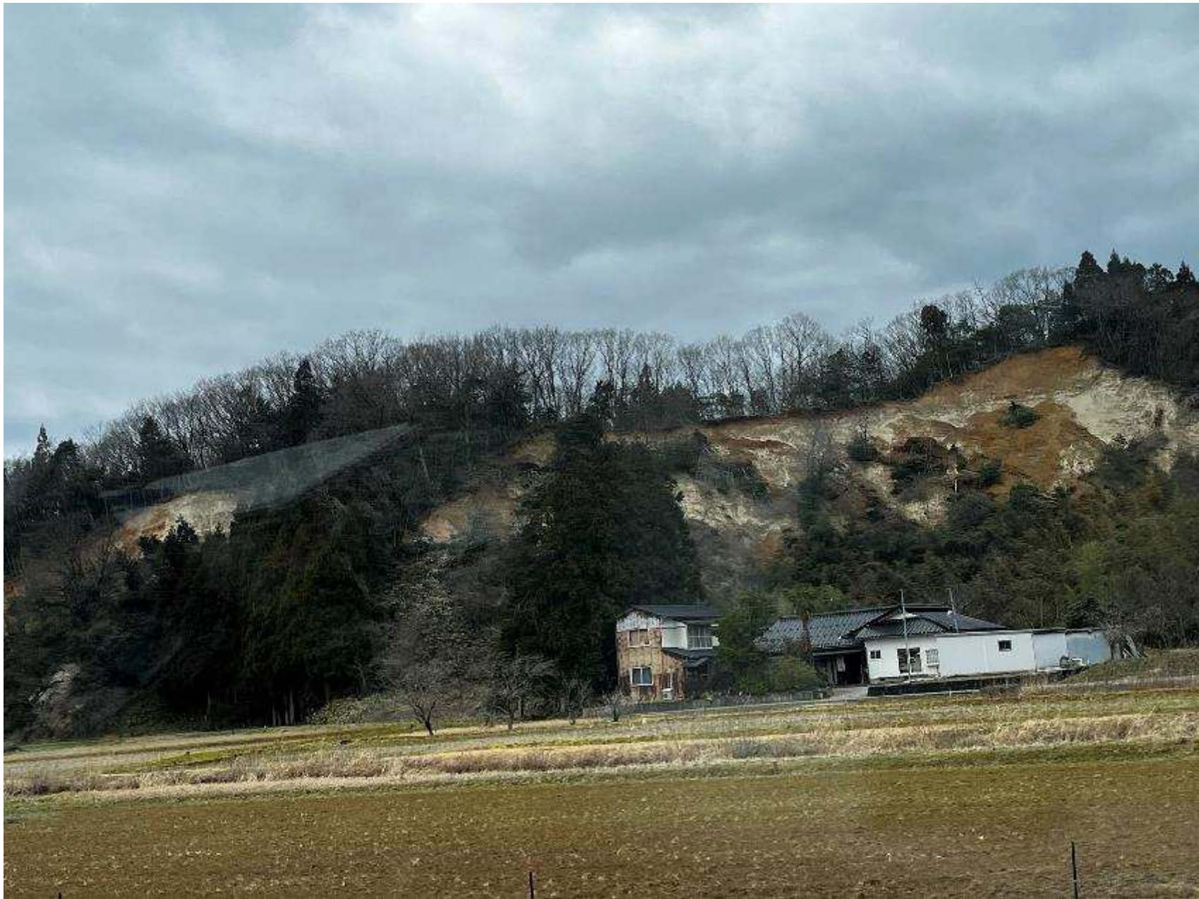
斜面崩壊の様子
