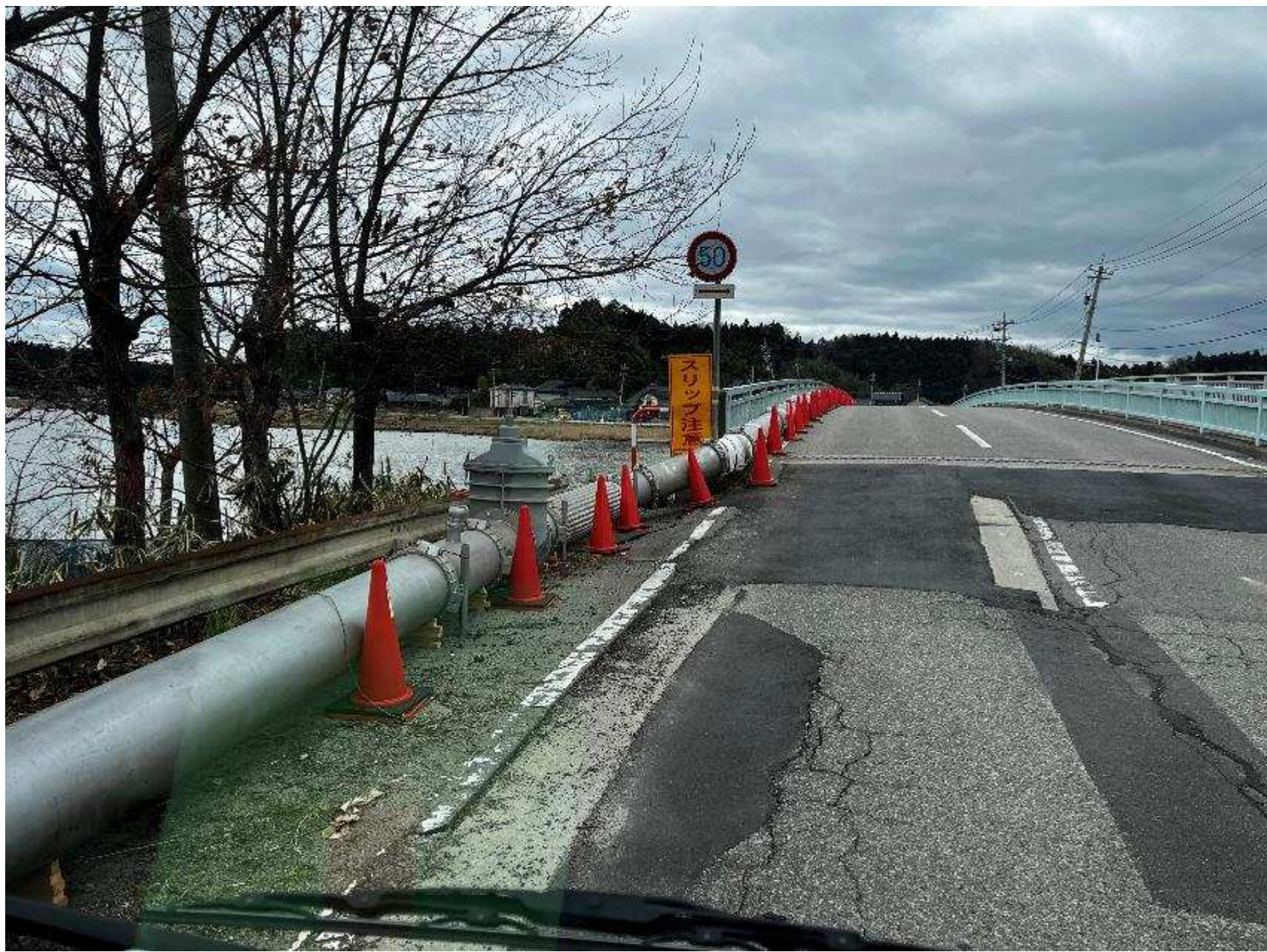
仮配管の様子
