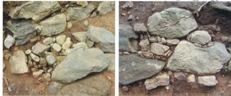
③石垣Ⅱ前に設けられた石枡 ④精微に詰められた間詰石
