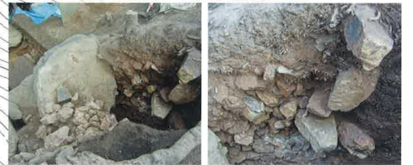
⑧石垣Ⅰの背後を上から見たところ ⑨左から石垣Ⅰの尻部、裏込石、土留石、造成土
