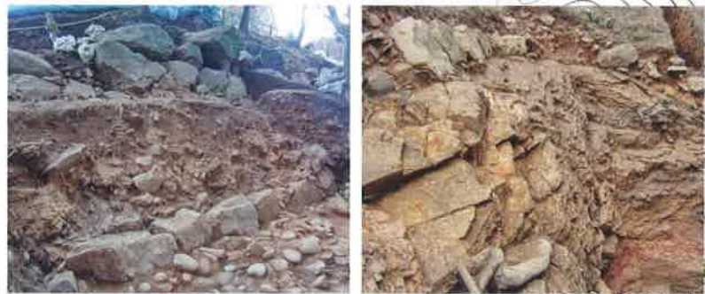
⑤段築された石垣(石垣Ⅰ・Ⅱ) ⑥岩盤加工の入隅と石垣
