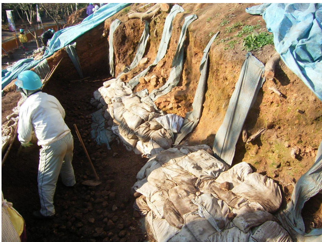
石垣保護の状況
