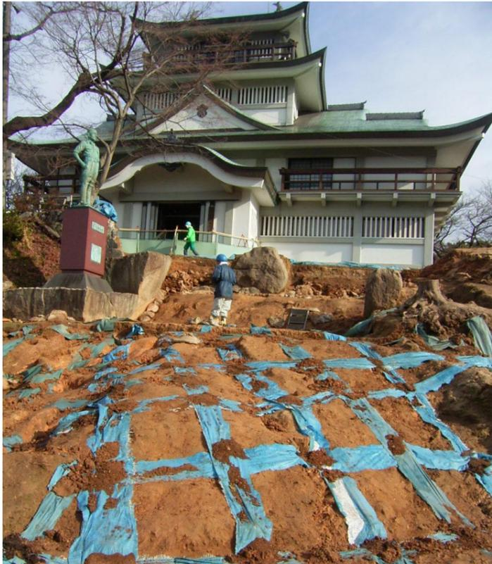
現地説明会開催後も小牧山では寒さに負けず、作業が続いています。歴史館南斜面の調査区（U区）では2月中旬までに全ての調査、記録作業が完了し、埋戻し作業に入りました。埋戻しに先立ち、確認したお城の面（遺構面）や検出した石垣などを土のうと養生シートで保護しました。
