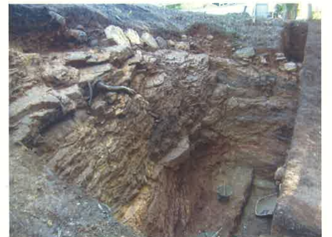
写真1 石垣Aと加工岩盤の入隅部
