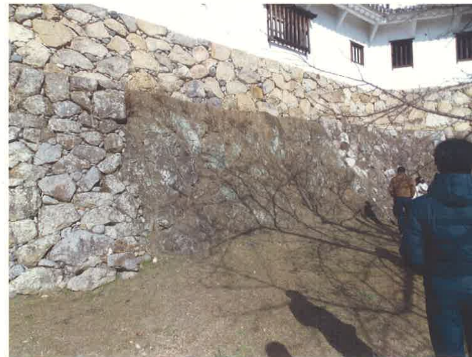
写真11 岩盤と石垣が併用される事例 (姫路城西の丸)
