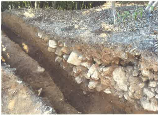
写真3 崩落した石垣石材の堆積状況
