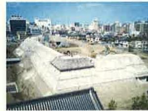
建物の表面に連続繊維補強土施工 (施工中)
