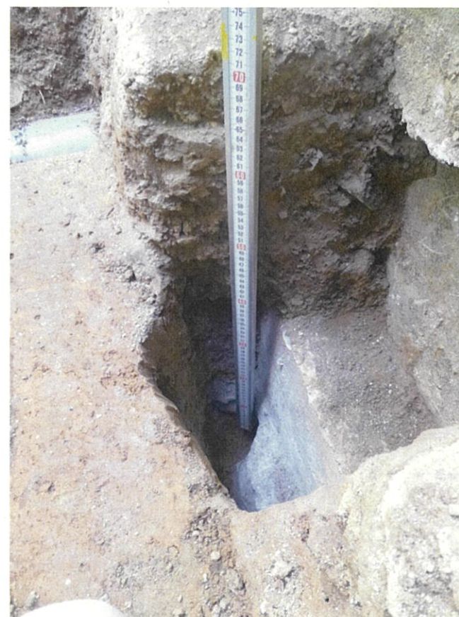
トイレ基礎部分掘り上がり状況 （南東から）
