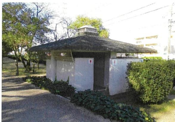
搦手口屋外トイレ
