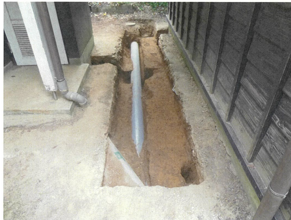
掘り上がり状況（南東から）
