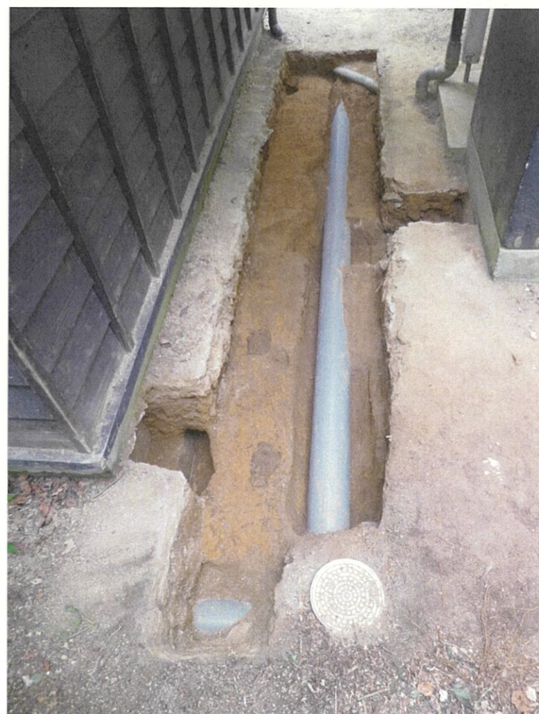
掘り上がり状況 （北西から）
