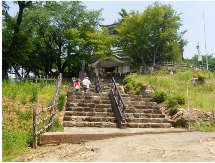
調査前の南側階段(大手口推定箇所)
