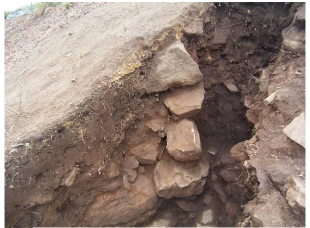
写真3 S区 石垣Ⅰの背面構造
