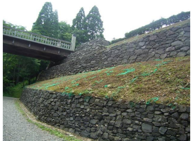
写真6 腰巻石垣の一例（八王子城・東京都）
