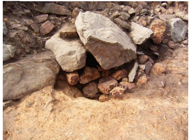
写真4 S区 石垣Ⅱ 崩落部分
