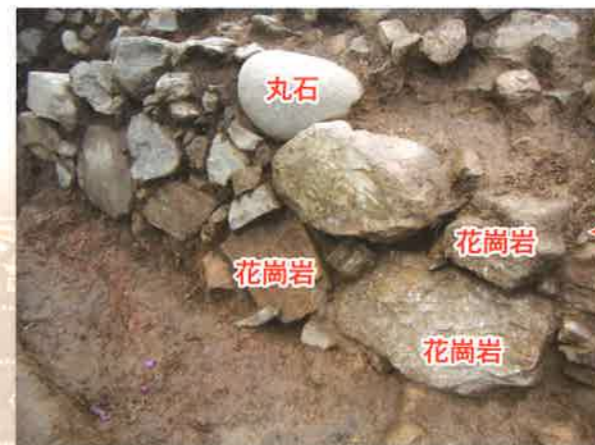
写真8 R区 石垣Ⅲ(近景)
