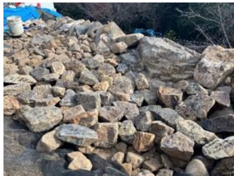
記名された石材の石垣背面充填状況
