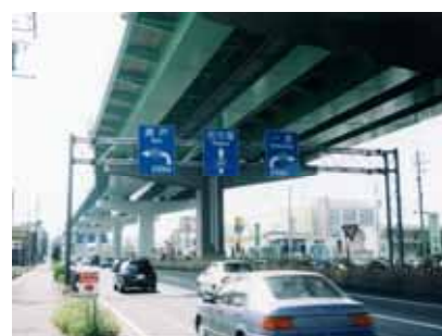
かつては開放的で見通しの開けていた国道 41 号も、名濃道路の建設が進み、道路景観は大きく変貌した。
