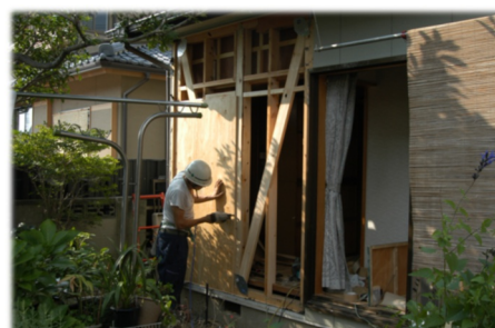
補助金を活用した耐震改修工事
