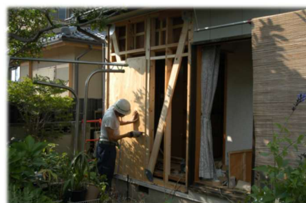
補助金を活用した耐震改修工事
