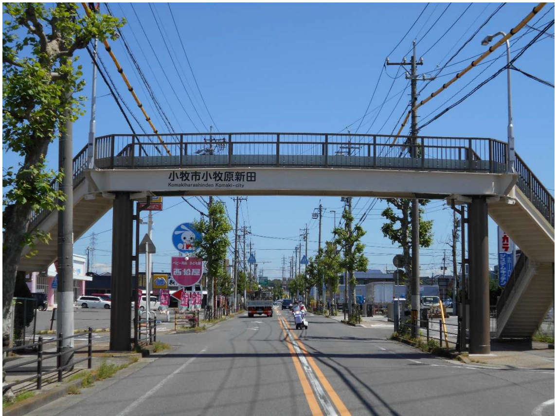
小牧原小学校前歩道橋
