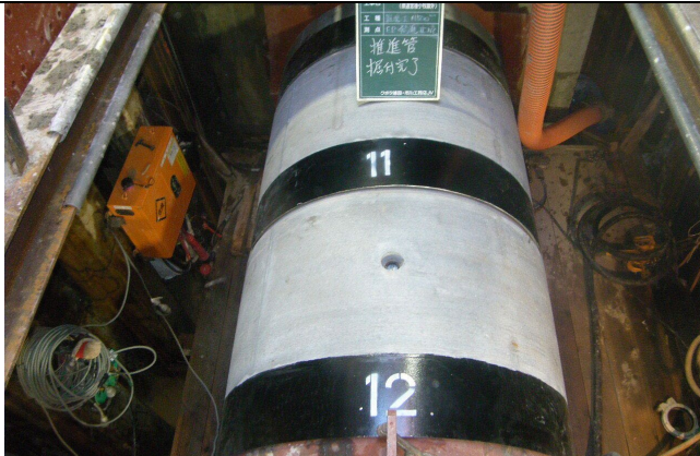
令和5年度実施 県道宮後小牧線外 φ500mm送水管布設工事
