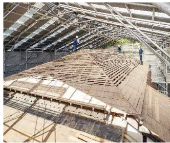
▲創垂館保存修理工事の様子
