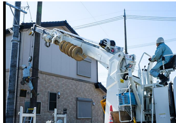
電柱を建てる
