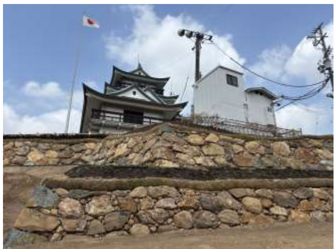
整備工事完了後の主郭地区第3-2工区
