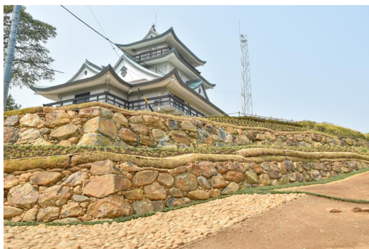
整備工事完了後の主郭地区第3-1工区
