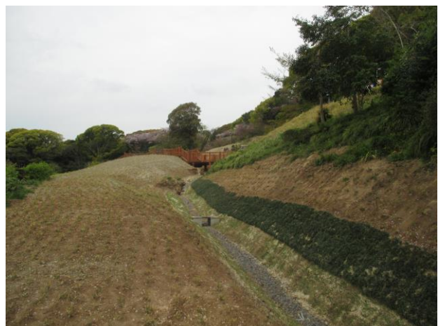
整備工事完了後の管理道部分
