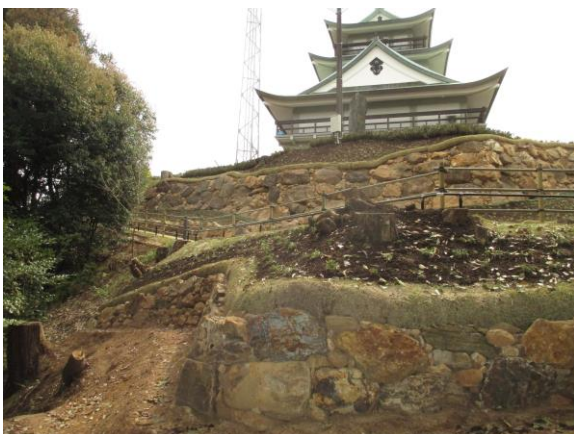
整備工事完了後の主郭地区第1工区
