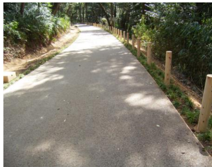
舗装工事完了後の 小牧山作業道
