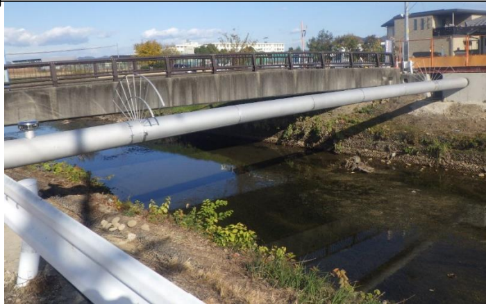
令和7年度実施 市道岩崎横内線外 φ500mm～φ50mm 送配水管布設工事
