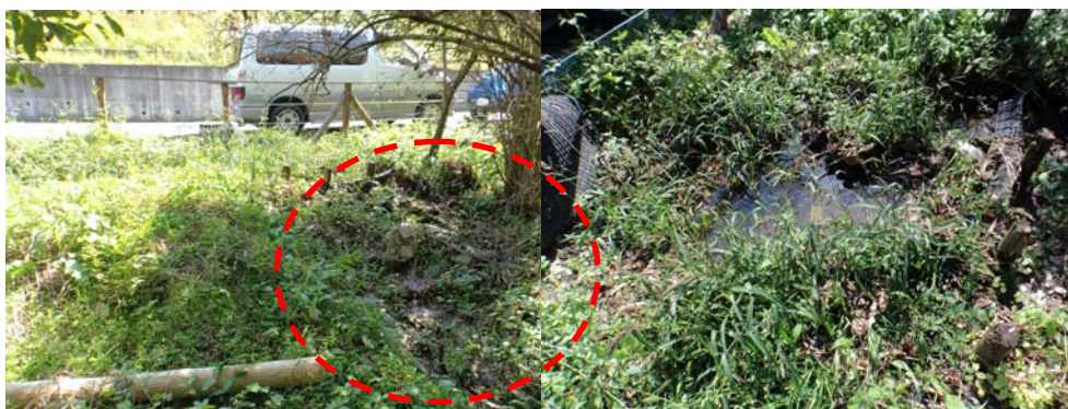
写真5-2 整備状況（周辺からの雨水排水処理）
