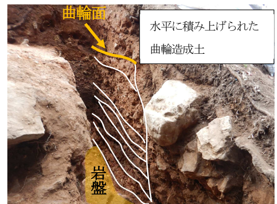
写真4 石垣背面の曲輪造成土の状況
