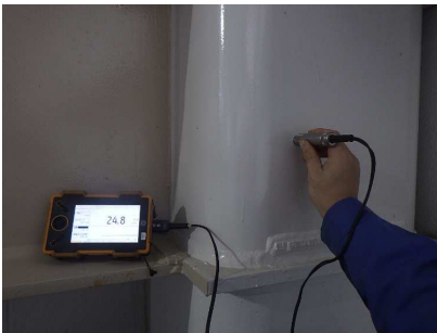
超音波計による板厚計測
