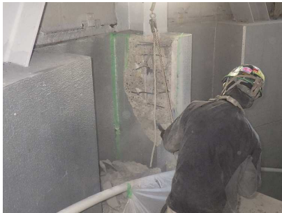
根巻躯体の研り状況
