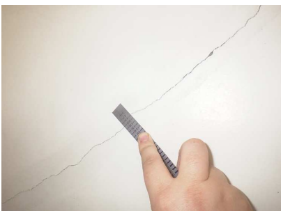
コンクリートひび割れ計測
