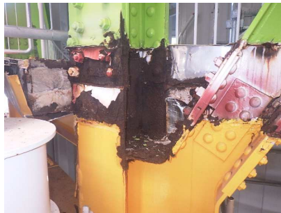
目視による劣化確認
