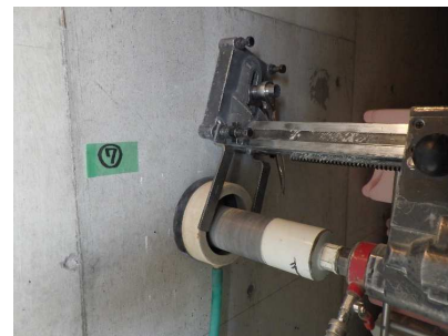
コンクリートコア掘削
