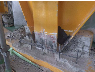
根巻躯体の研り状況
