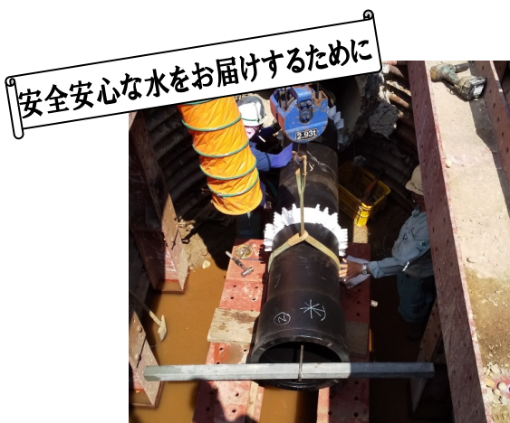
R1 実施 市道犬山公園線φ400mm～φ50mm 配水管布設工事
