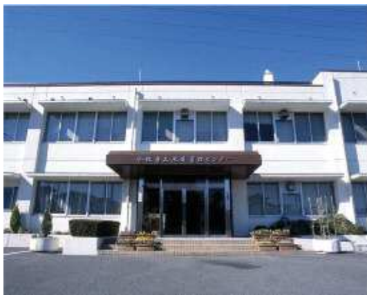
上水道管理センター
