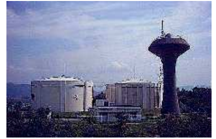
(写真) 桃花台配水池
