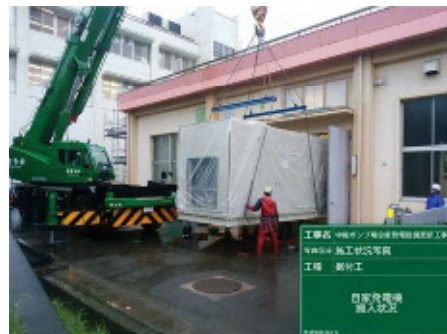
自家発電機搬入作業の様子
