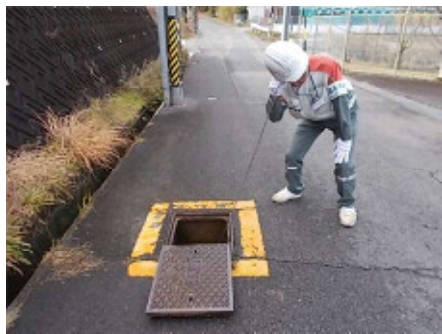
漏水調査作業の様子
