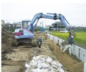
工事中の市之久田公園
