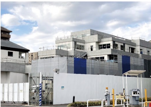
建設中の新図書館
