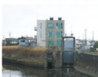
藤島雨水ポンプ場
