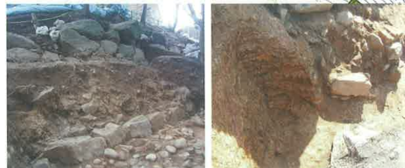
⑦上下2段の石垣 ⑧岩盤加工の入隅と石垣
