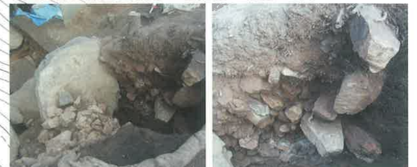
⑪石垣の裏を上から見たところ ⑫左から石垣の尻部、裏込石、土留石、造成土
