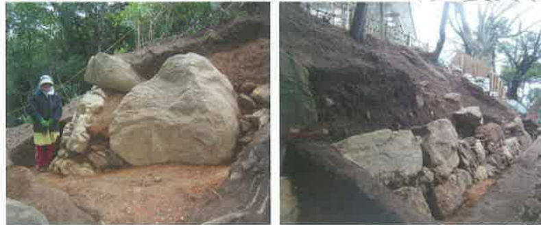
①北西の張出し部は特に巨石が使用されている ②残存するのは基底部付近の2~3段でさらに3~4段石垣が積まれていたと推定される
