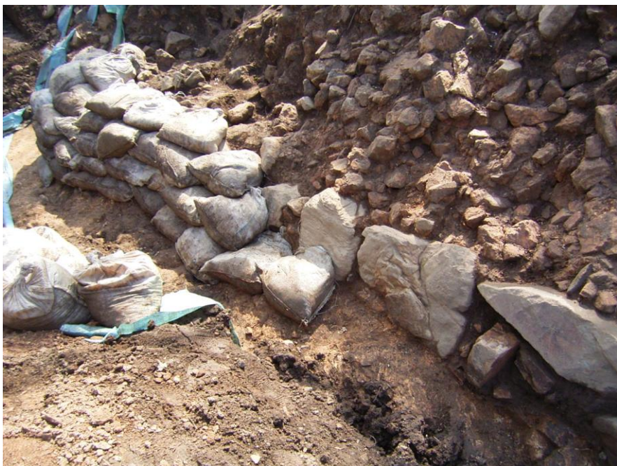
土嚢による石垣保護の状況
